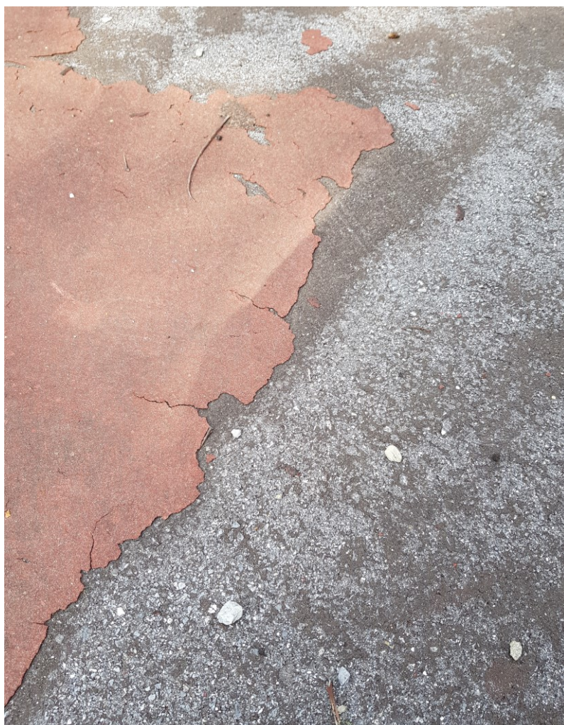
Immagine 3: particolare di una delle zone con la pavimentazione asportata e sottofondo in binder
