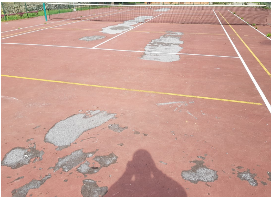
Immagine 2: vista del fondo ammalorato del campetto
