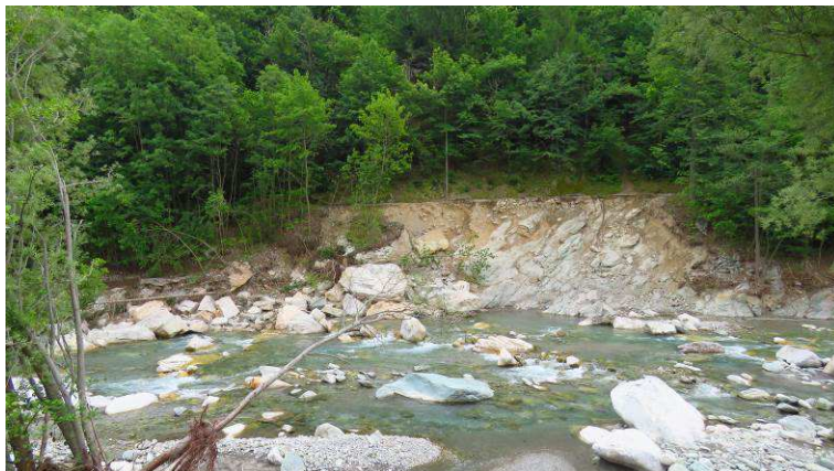
Foto n° 3: intervento località Condominio Vallette; nella scarpata d'erosione affiora estesamente il substrato roccioso. La massicciata stradale è stata asportata per buona parte.
