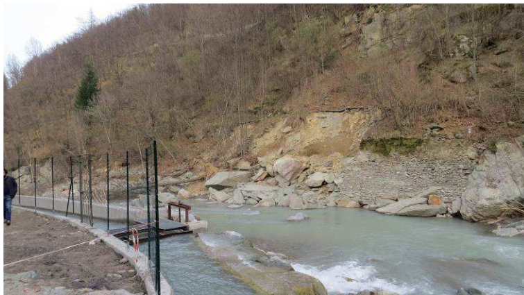
Foto n° 6: intervento località Area camper (a tergo del muro crollato sono presenti terreni di riporto e depositi di grossi blocchi derivanti da una antica frana di crollo che ha interessato il versante a monte della strada comunale)
