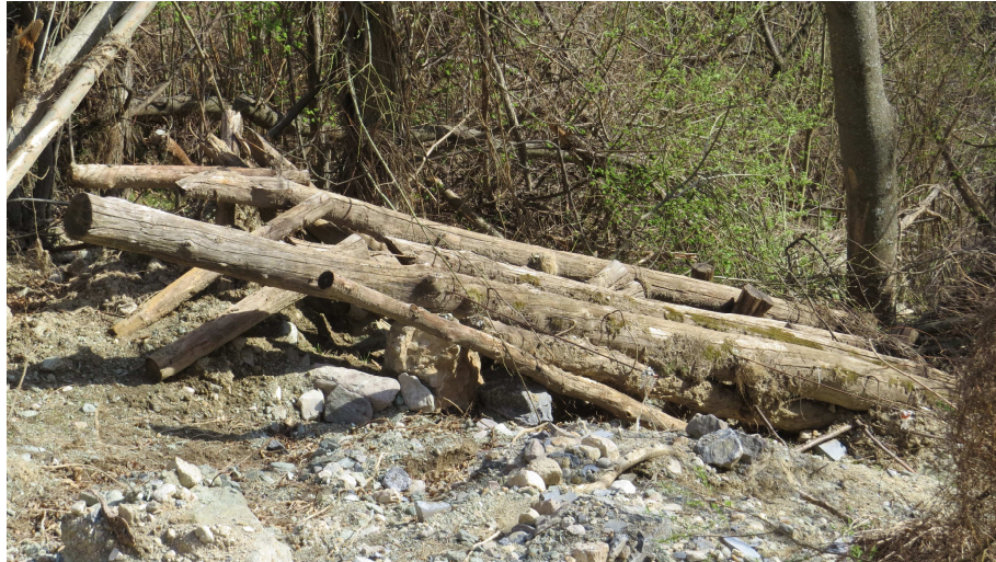
Foto n° 3: nella zona d'accumulo della frana sono presenti i resti della palificata di sostegno in legname e pietrame
