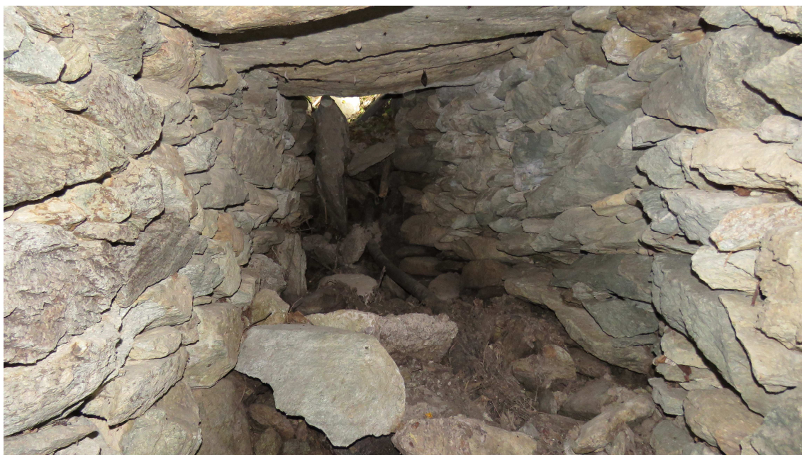
Foto n° 7: Particolare attraversamento da disostruire e consolidare
