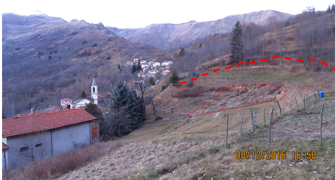
Foto n° 3: il dissesto con parziale evoluzione a colata è avvenuto a carico dei terreni di copertura nell'ambito di un largo impluvio a valle del quale sono presenti le abitazioni della borgata. Un coronamento molto più esteso evidenzia l'effettivo sviluppo del settore in dissesto incipiente
